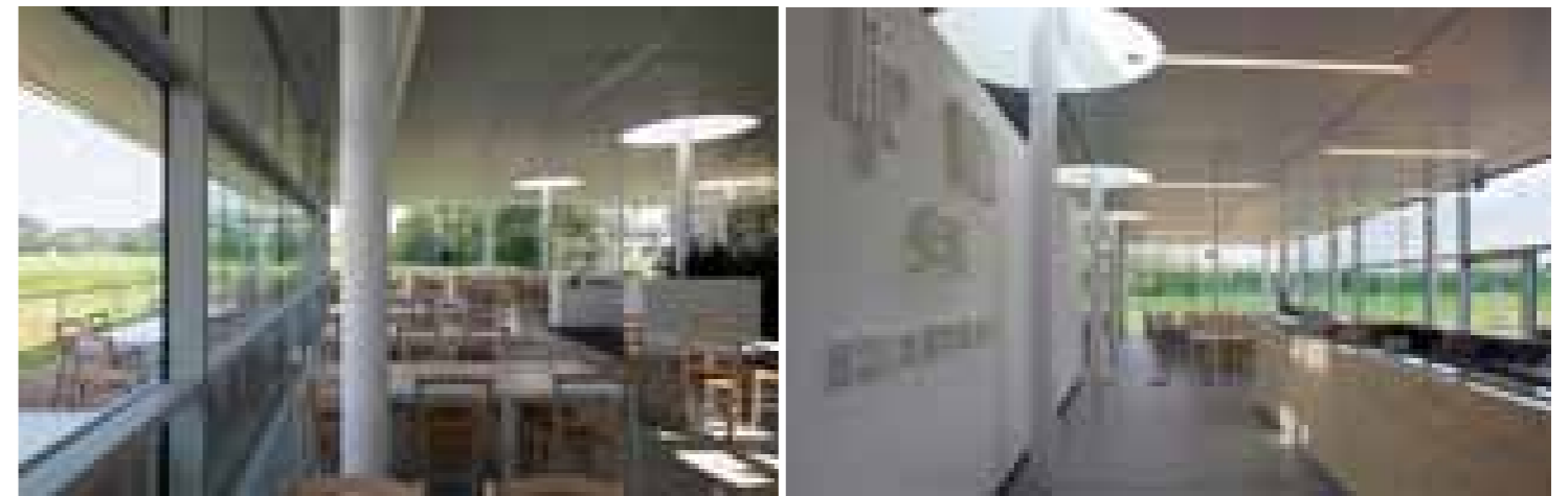
ESTERNI ED INTERNI DEL RISTORANTE AZIENDALE ZAMBON , CHE COSTITUISCE IL PRIMO INTERVENTO DI SVILUPPO DEL "POLO DI ECCELLENZA PER L'INNOVAZIONE E LA RICERCA TECNOLOGICA", DENOMINATO OPEN ZONE, NEL COMUNE DI BRESSO, ALL'INTERNO DEL PARCO NORD MILANO. L'EDIFICIO SI SVILUPPA SU UNA PIANTA QUADRATA DI 30 M DI LATO ED È OPERA DELLO STUDIO MILANESE VITTORIO GRASSI ARCHITETTO & PARTNERS.
